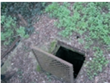
Pou actualment cobert per una estructura de formigó.
