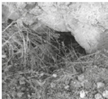
Part superior del mur on encara es pot veure part de l'entrada de la galeria.
